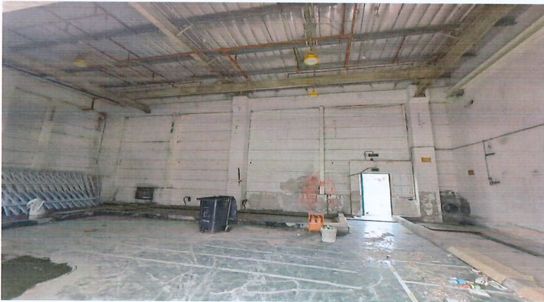
附属栋3 内部照片
